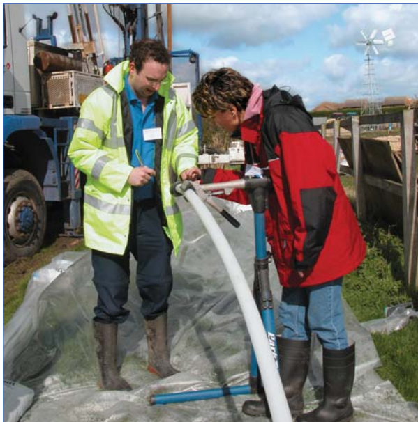
Construcción de los puertos de CMT de 7 canales en Silsoe, Inglaterra
