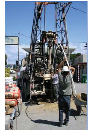
Una estación de gasolina en Watsonville, California. Se instalaron 5 sistemas CMT de 3 canales para monitorear la pluma de contaminación de MTBE. Las instalaciones se finalizaron dentro de barrenos huecos utilizando bentonita y arena para aislar cada zona.
