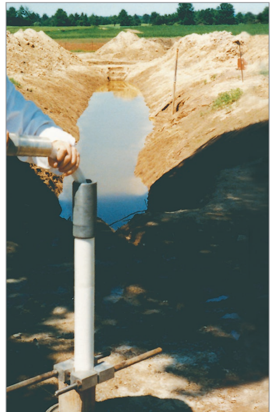
Evaluación de fuga de tubería subterránea de petróleo. Tres instalaciones de 150 pies (45 m). Se realizaron dos pruebas de permeabilidad de cabezal de elevación de dos puntos en cada intervalo del sistema de niveles múltiples. (Consulte el diagrama de la izquierda que muestra la distribución de contaminantes.)
