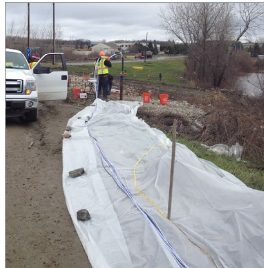
Se instalaron cinco sistemas Waterloo a 33,5 m (110 pies) en un lecho rocoso fracturado para ayudar a caracterizar una columna de clorobenceno histórica en el sitio de una bomba de agua subterránea propuesta y un sitio de tratamiento. Los transductores de cuerda vibrante y las bombas de válvula doble se dedicaron a cada una de las 4 zonas de monitoreo.
