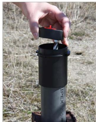
Placez le support de suspension dans la base du couvercle du puits de manière à ce qu'il repose sur l'épaulement dans la base. Placez l'insert dans la même base du couvercle du puits.
