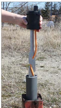
Soulevez la base du couvercle de puits avec le support de suspension et l'insert du tubage du puits. Enroulez le câble ventilé autour du support de suspension, puis faites-le glisser dans les encoches pour fixer le câble au support.
