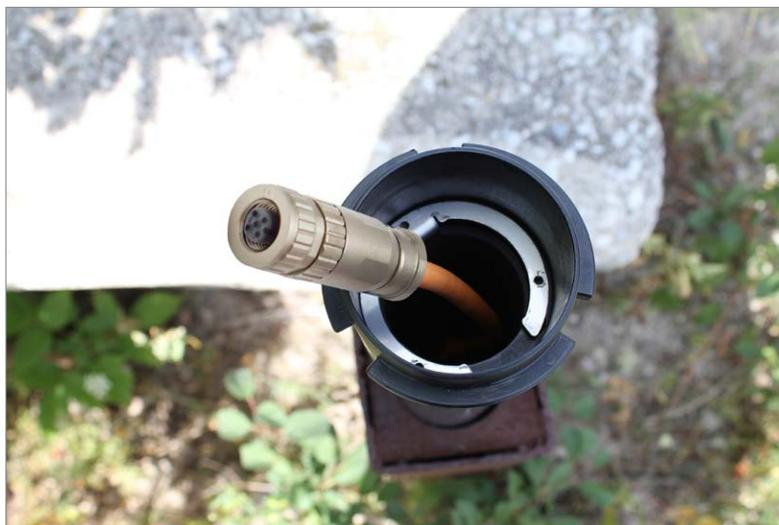
Abaissez le support de suspension dans le puits jusqu'à ce qu'il repose sur l'épaulement dans la base du couvercle du puits.
