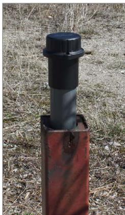
Rabaissez l'ensemble de couvercle de puits sur le tubage de puits. Fixez la base du couvercle du puits sur le tubage de puits si vous le souhaitez. Installez le couvercle du puits. **Remarque : il est possible que vous ayez besoin de retirer le bouchon anti-poussière de la tête de puits LevelVent Wellhead avant d'installer le couvercle de puits..**
