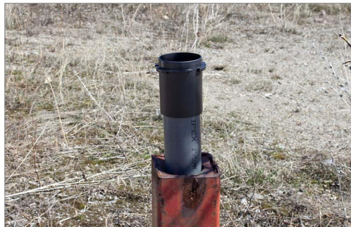
Faites glisser la base du couvercle du puits sur le tubage de puits. Ne la fixez pas pour l'instant.
