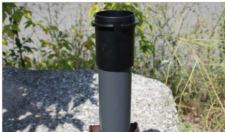
Installez la base du couvercle du puits sur le tubage de puits.
